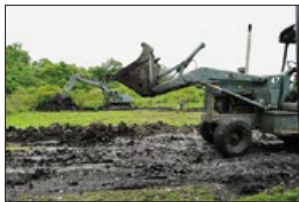
3. Excavaciones empleando maquinaria
