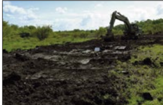
Excavación en zona fangosa
