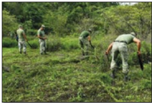
2. Limpieza del área de intervención
