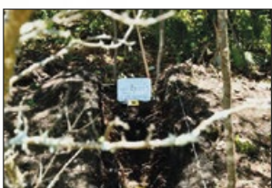
5. Elaboración de pozo de sondeo
